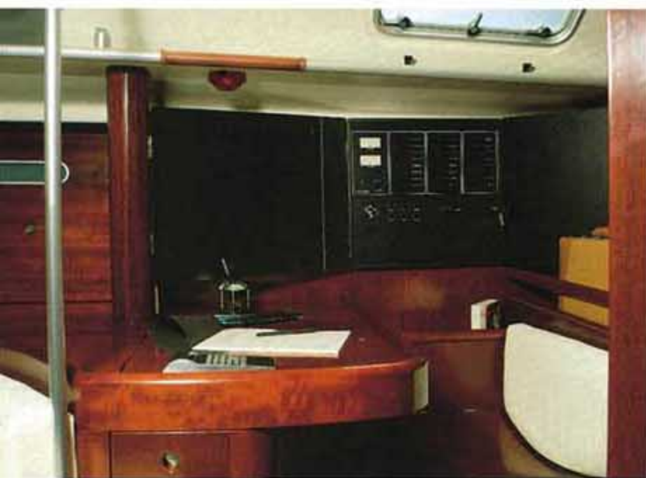
L'«espace navigation» et sa centrale de commandes électriques.
